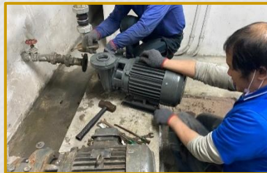
揚水泵補更新
