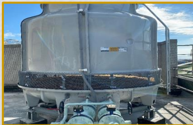
水塔更新工程
