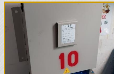
變壓器更新工程
