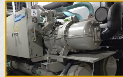
冰水主機更新工程
