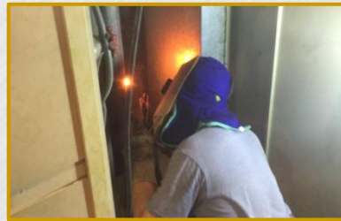
管路燒焊工程
