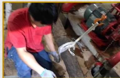
消防設備修繕
