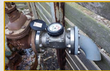
閘閥更新工程
